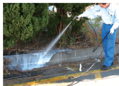
専門業者による液剤の高圧散布
