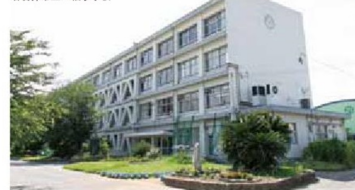
ACP導入を本格的にスタートさせた 春日井市立八幡小学校
